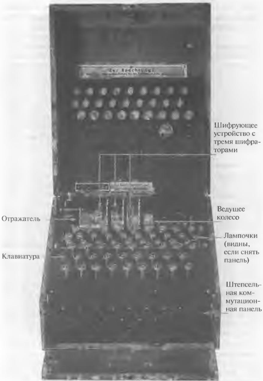
Рис. 40 «Энигма» со снятой внутренней крышкой; видны три шифратора.
